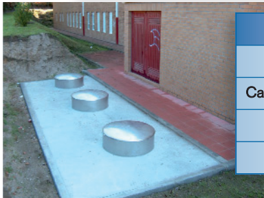
Figura 4. Detalle y datos de los depósitos enterrados en la instalación.
